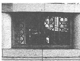
写真-23 神田橋 高欄
