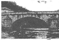
写真-5: アンペル橋 (1788) 18
