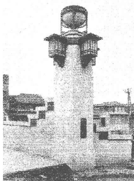
写真－6 船河原橋の親柱
