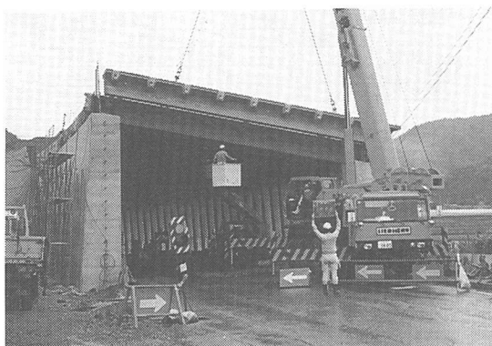
写真-2 PC製スノーシェッドの工事状況
