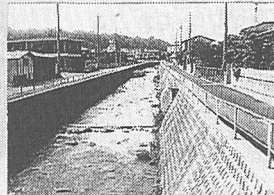
写真-5 黒沢川 現況 (H. 7)
