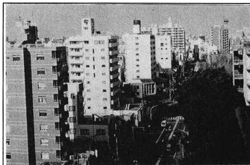
写真1 ほぼ無規制で設置される屋上構造物 (東京都文京区／本郷通り沿い)
