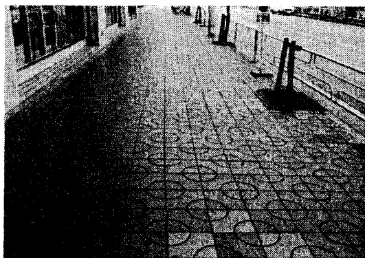
写真3 カラーコンクリートブロック舗装
