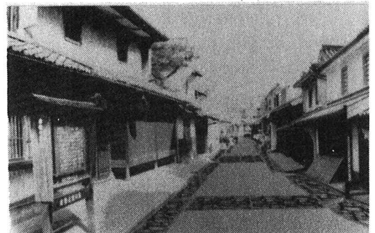
(b) 電柱・架空線除去、建物修景、道路整備後 写真4-1 景観シミュレーションの結果
