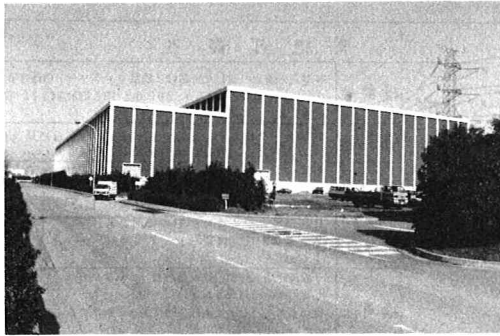
i) 屋内開閉所 タービン建屋(図.8)と同デザイン
