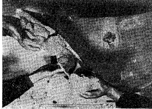
図-48 (b) 右岸のアバットメントに隣接する部分に生じたせん断破壊(模型-3)
