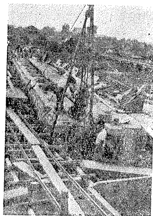
写真-3.4 主桁第 1 次緊張作業
