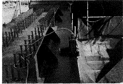
写真-7 傾斜角計の設置状況
