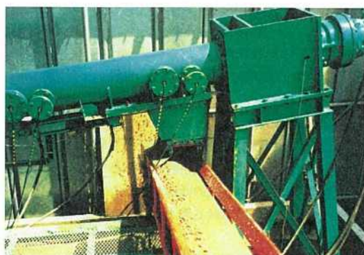
写真-5 細砂・不安定時の排土状況
