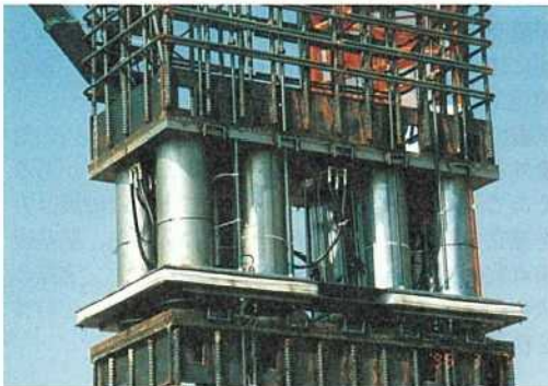
写真-1 ジャッキ装着状態
