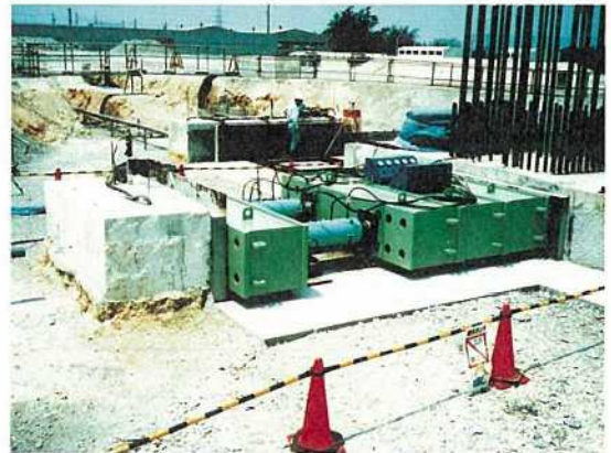
写真-2 載荷装置全景
