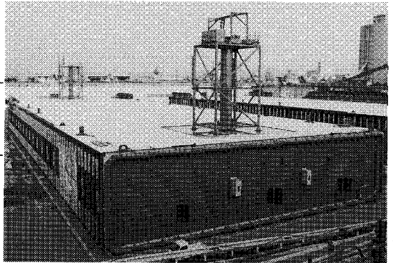
写真-2 沈埋函完成時
