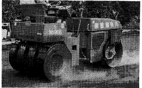
写真-3 アスファルトコンクリートの転圧作業
