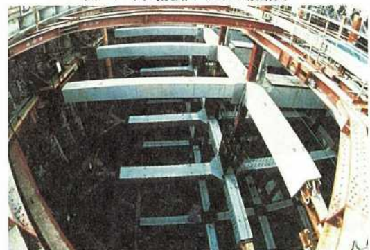
写真-1 プレキャストSRC切ばり方式土留め工法
