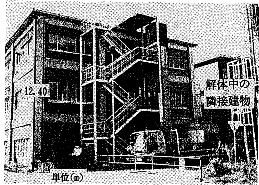
(a) 供用時(北面より撮影)
