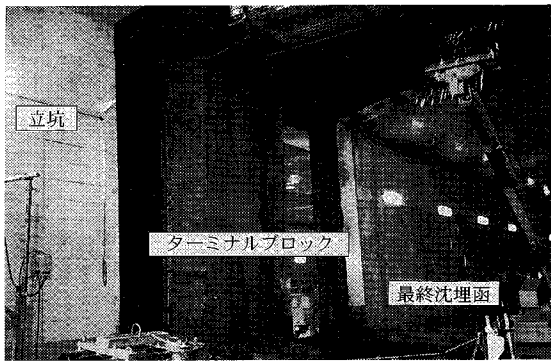
写真一 2 最終継手貫通状況
