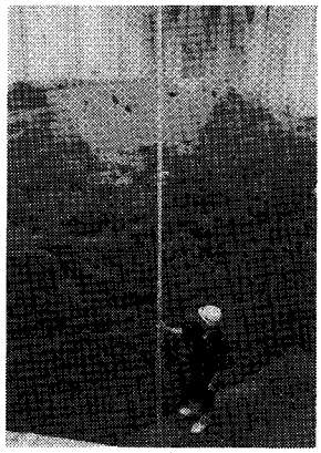
写真一三 処理地盤の掘削断面
