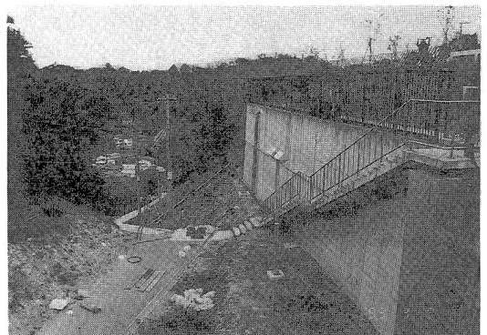
写真-1 EPS盛土部の鉄筋コンクリート擁壁外観
