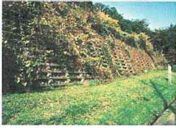
(I) 格子状ブロック組 裏込栗石法尻草地在り
