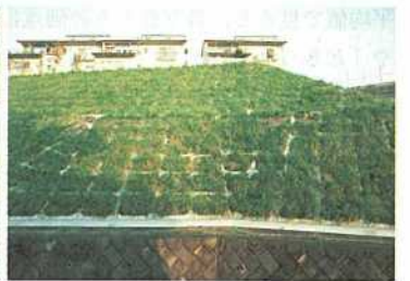
(XII) 緩斜面現場打ち法枠 ブロック枠内牧草風
