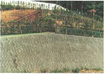
(VII) 標準品矩形ブロック積み 上部法肩植樹有り
