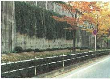
(VIII) 直壁上部ツル科植物の 垂下り下部植込有り
