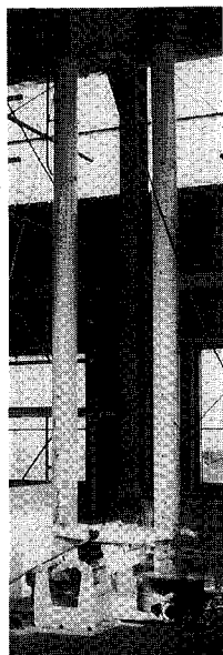
写真-2 落錘衝撃載荷装置
