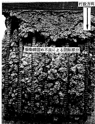
写真—6 通常型内部振動機で締固めたL型鉄筋コンクリート試験体の締固め後の状況
