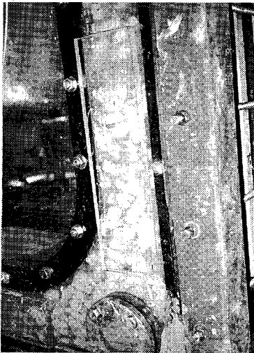
写真-2 上部からの注入
