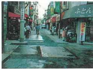
(a) 施工前の写真画像
