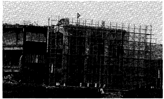
写真-2 倒壊状況 (初段発破直後, ≒DS#2)
