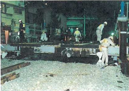
写真一 2 扛上作業
