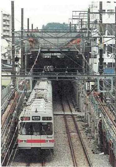
写真-5 切替前 (平成3年10月19日)
