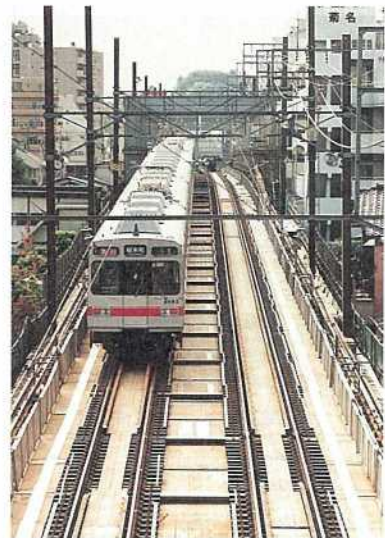
写真-6 切替後 (平成3年10月20日)
