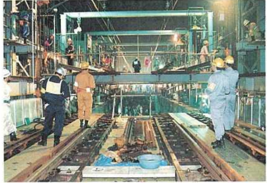
写真一 3 降下作業
