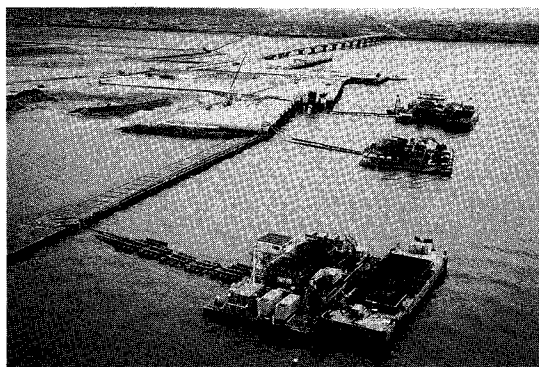
写真—2 空気圧送船の施工状況
