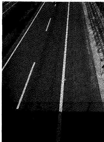
写真-1 典型的な縦表面ひびわれの状況
