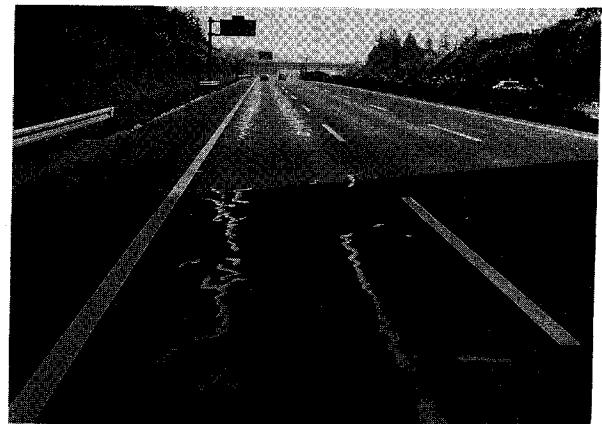
写真-3 オーバープリッジの下の縦表面ひびわれ
