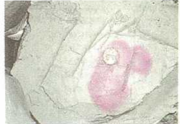
写真一七 C点における注入状況
