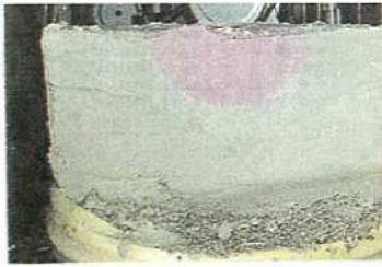
写真一五 A点における注入状況
