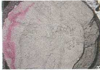
写真一六 B点における注入状況
