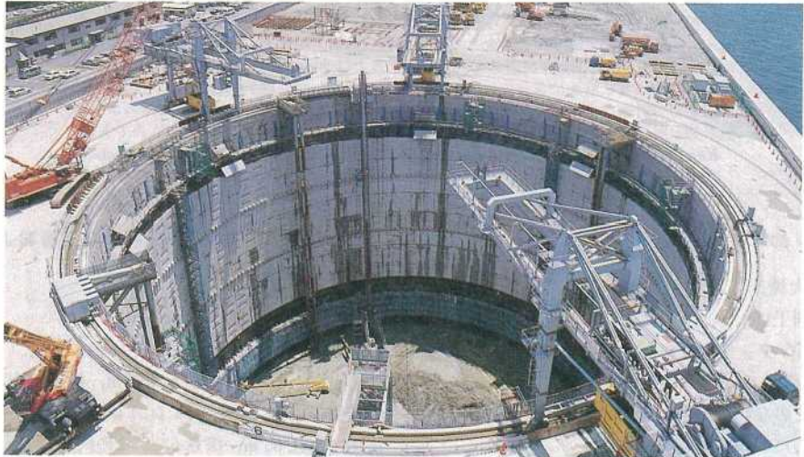
写真-1 掘削状況
