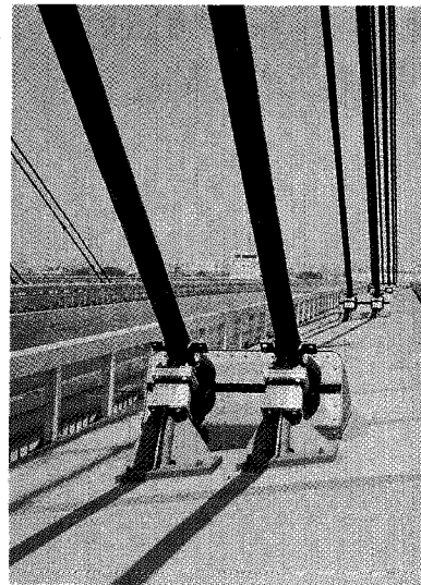
写真一 ケーブル制振用ダンパーの設置状況
