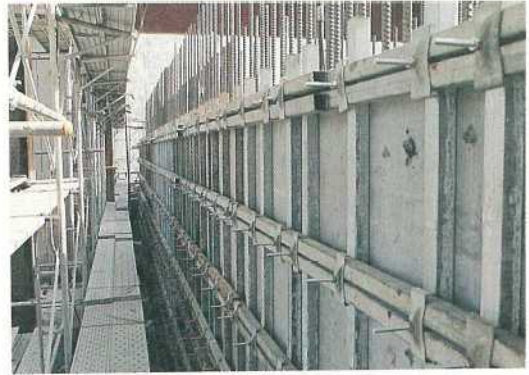
写真一六 PICフォームの設置状況
