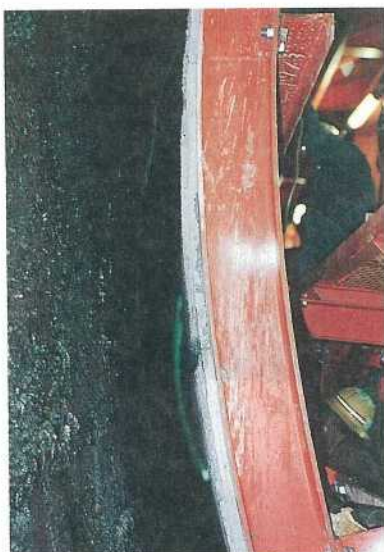
写真-3 セントルに取り付けたPICフォーム
