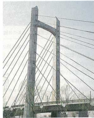
写真一〇 PC斜張橋の主塔への適用
