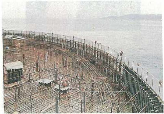
写真一八 大型海上橋梁基礎への設置状況
