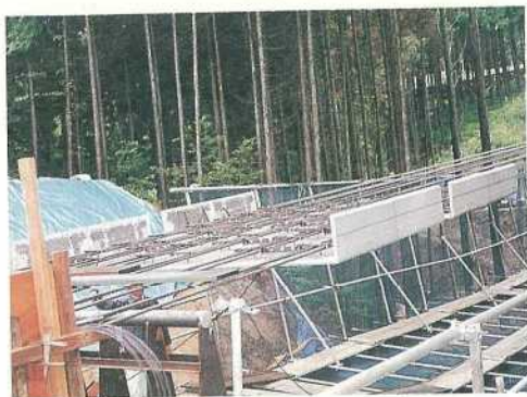
写真-12 ユニット化による施工状況
