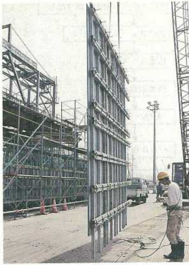
写真一五 PICフォームの大パネル化
