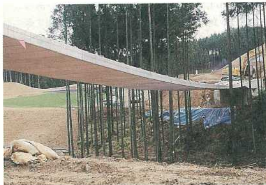
写真一一 吊床版橋への適用
