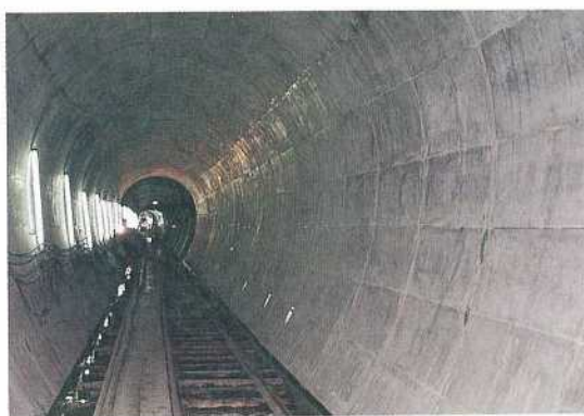
写真-4 補修の完了した水路トンネルの外観
