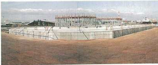
写真一七 大型海上橋梁基礎完成状況
