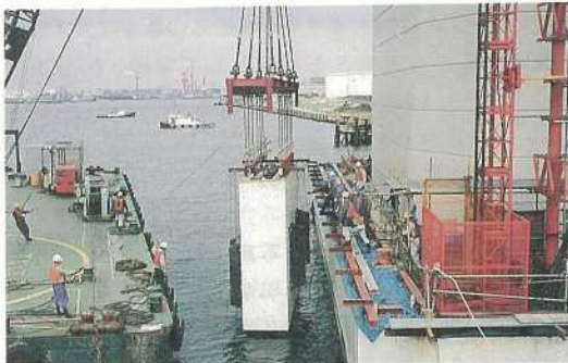
写真一九 海上橋梁基礎の緩衝工の組み立て状況
