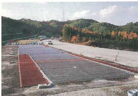
写真-3 路面ヒートパイプ方式
