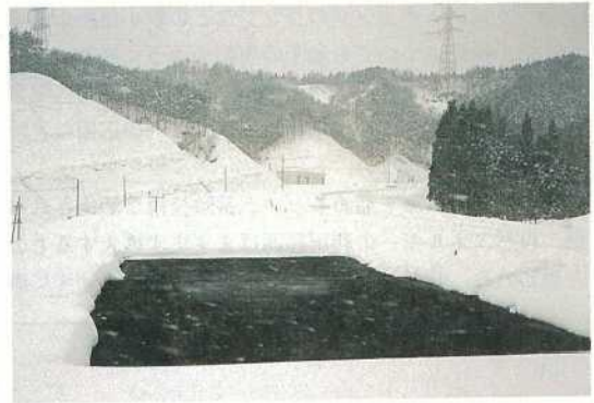
写真-6 融雪状況 (供用前)
