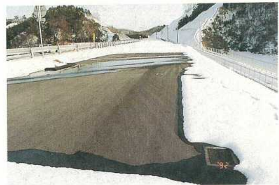
写真-7 融雪状況 (供用後)
