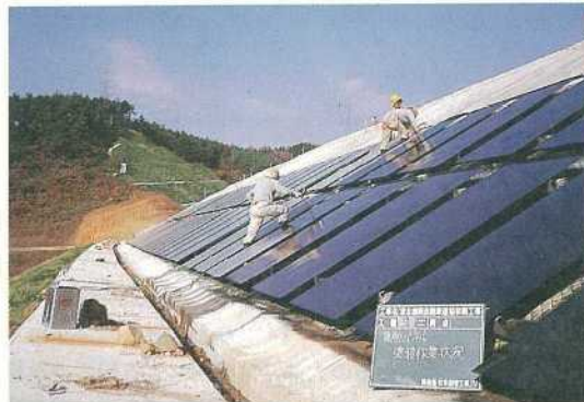
写真-5 のり面ヒートパネル方式
