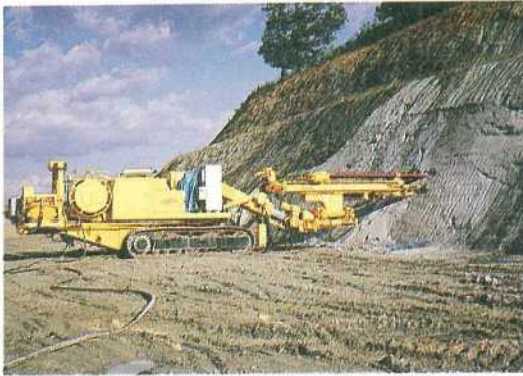
写真-1 土丹層試験施工中
