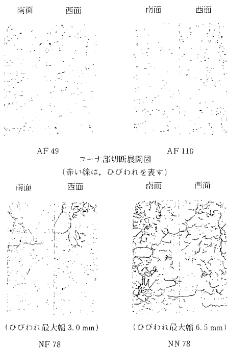
図-2 大型ブロックの内部状況 (暴露開始後 18 年)
