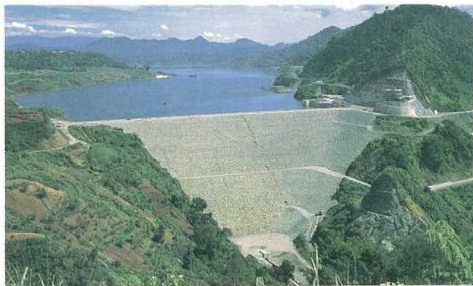
写真—4 チラタ水力発電所 インドネシアのジャワ島に建設された50万kWの発電所は同国最大規模の国家プロジェクト。ダムは黒四ダムの約10倍にあたる湖なみの水を貯える 12) 。
