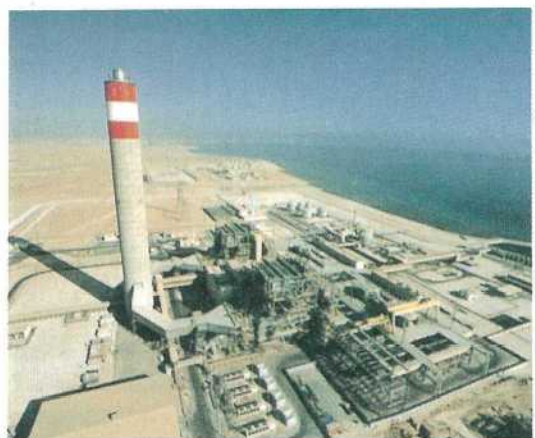
写真—6 クライヤ火力発電所 サウジアラビアのダンマンの南約100kmの砂漠に建設された120万kWの火力発電所 12) 。
