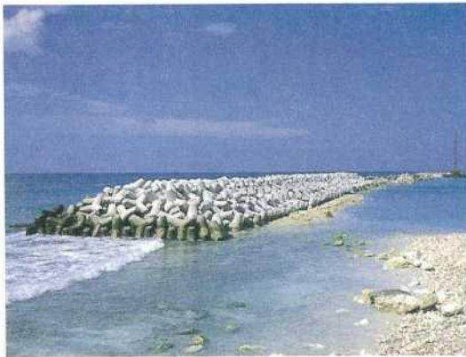
写真一 マレ島消波堤 モルディブ共和国の首都・マレ島において侵食被害を防ぐために消波施設工事が施された 11) 。
