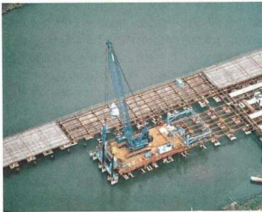
写真-4 台風後の冠水時に施工中の STEP 工法
