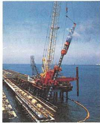
写真-1 臨海杭打装置 (実証実験機)
