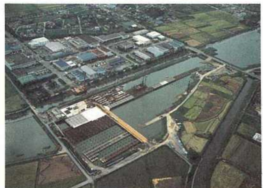
写真-3 埼玉県南卸売団地人工地盤全景
