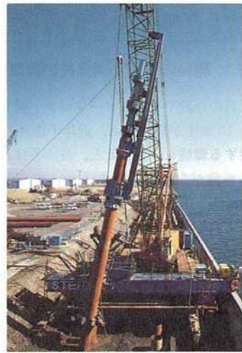
写真-2 浦安流通センターでの杭打ち
