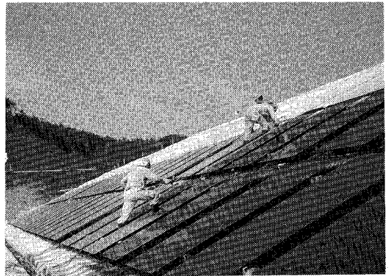
写真一 のり面ヒートパイプパネルの施工
