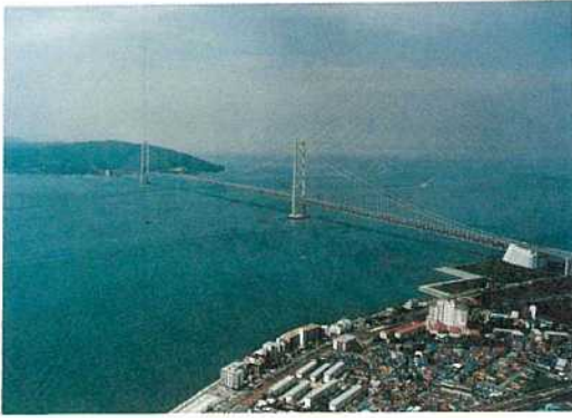
写真-3 明石海峡大橋 (本四公団提供)
