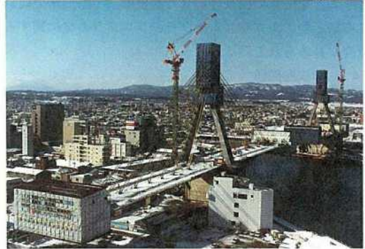
写真-2 青森ベイブリッジ (施工中)
