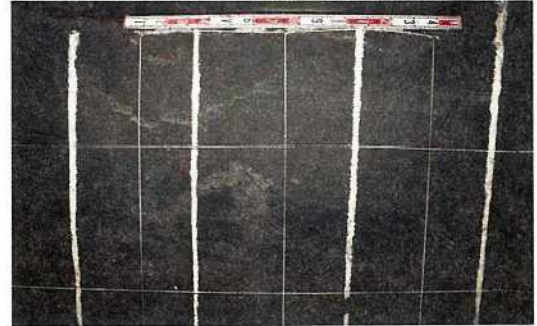
写真一〇 ケースⅤの荷重板直下
