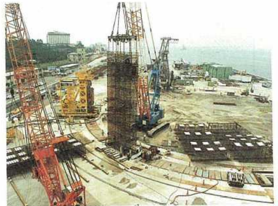
写真-4 鉄筋籠建て込み
