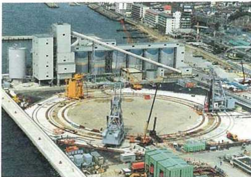
写真-1 掘削風景
