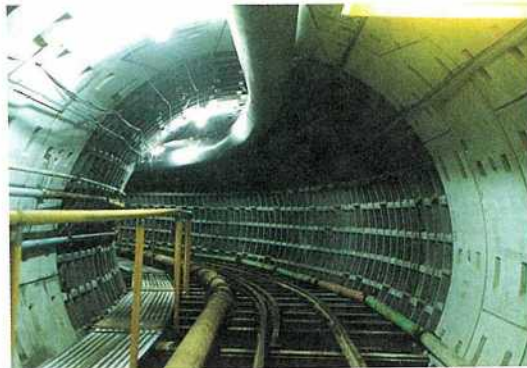
写真-2 R=20 m 箇所トンネル内状況
