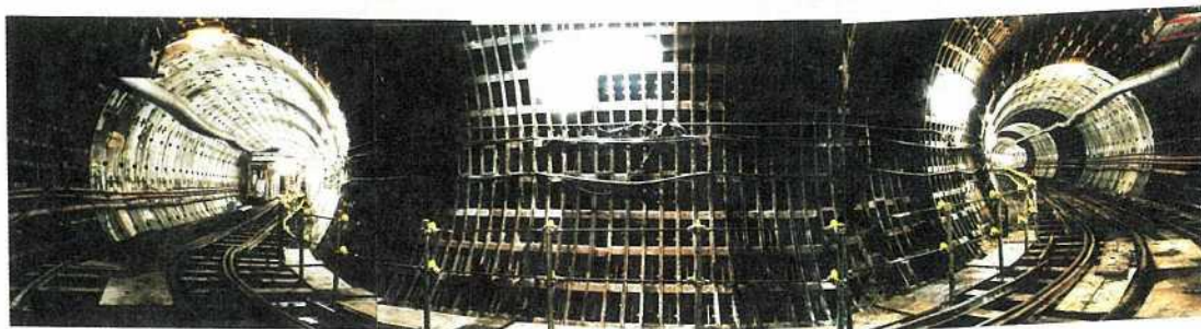
写真-4 R=10 m 箇所トンネル内状況
