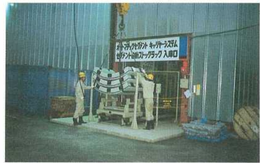
写真-2 セグメント入庫状況
