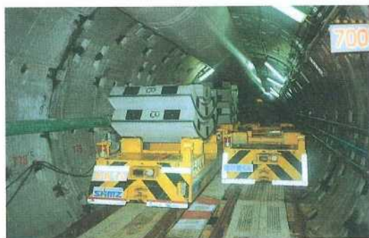
写真-4 自動走行台車のすれ違い状況
