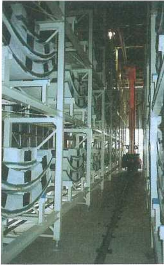
写真-1 自動ストックラック内部
