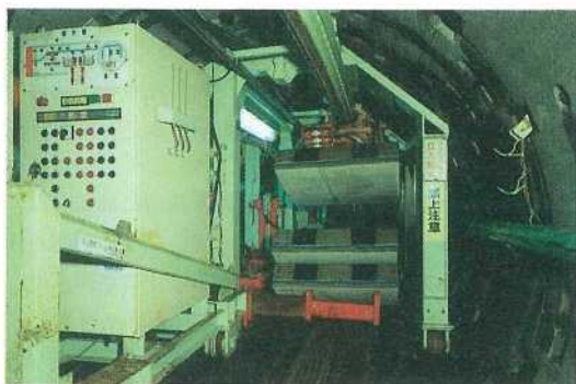
写真-7 セグメント供給装置
