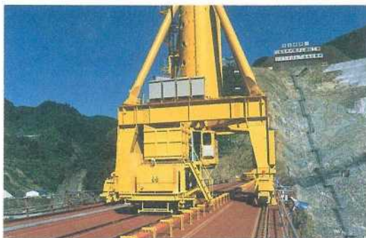
写真-1 タワークレーン走行架台
