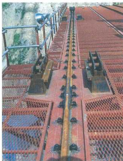
写真-1 タワークレーン走行架台
