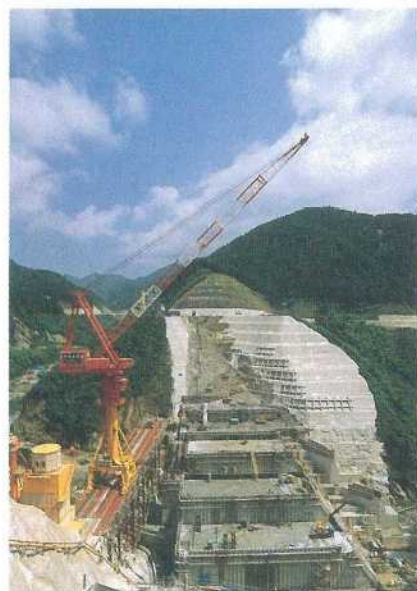
写真-7 コンクリート打設の状況
