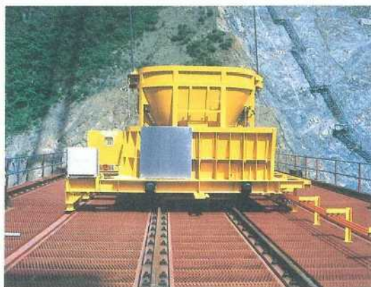
写真-6 コンクリートバケット着床状況
