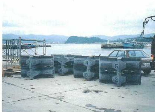
写真-4 北海道中央水産試験場の前浜に沈設したフェライト魚礁
