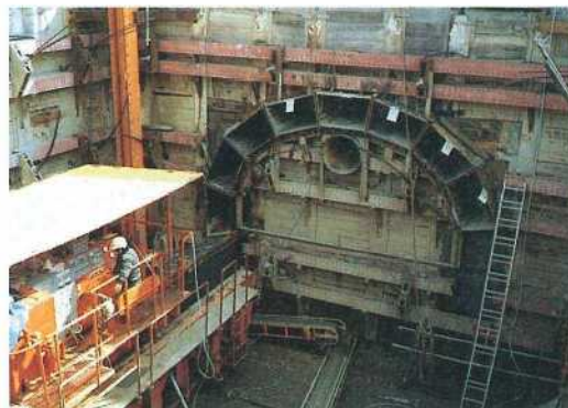
写真-2 トンネル方式 URT工法の施工状況例 (東海道本線守山駅構内 3.6×3.0×49 m, 1986年)
