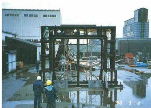
写真一七 エレメントの PC 横締め施工実験 (PC ストランド挿入作業)
