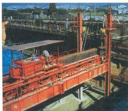
写真-1 下路桁方式 URT工法の施工状況例 (武豊線東浦・亀崎間 23.3×5.6×11 m, 1985年)
