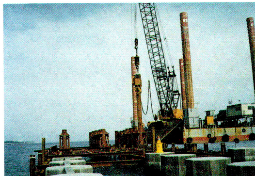
写真一七 垂直定規を用いた鋼管杭の打設
