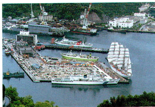
写真-1 八幡浜港フェリー・棧橋
