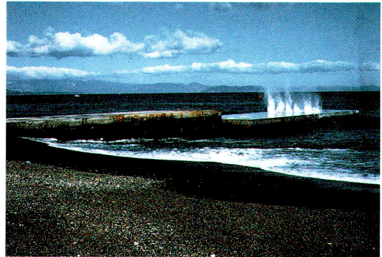
写真-5 導流堤 (北海道知内町)
