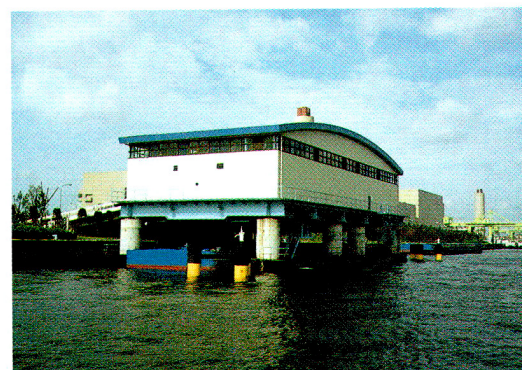
写真-3 岸壁 (東京都大田区)
