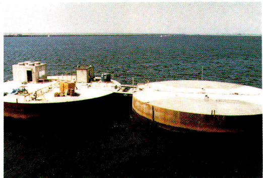
写真—4 載荷試験
