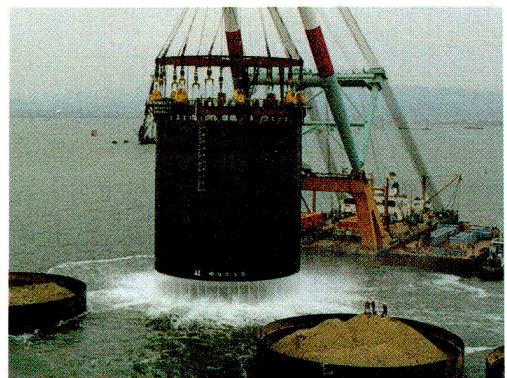
写真一八 ウォータージェット併用による打ち込み状況
