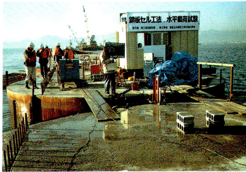
写真一六 載荷試験
