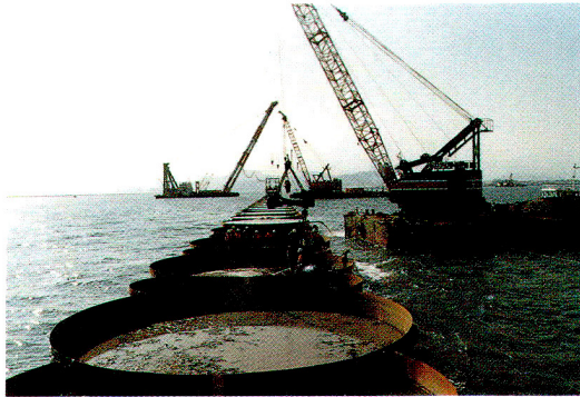
写真一五 外海での施工状況
