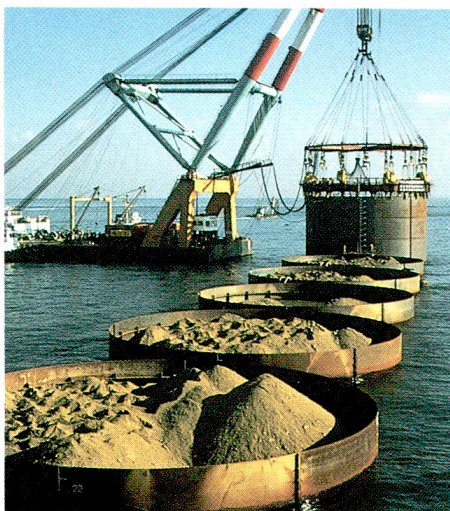
写真—1 鋼板セルの施工
